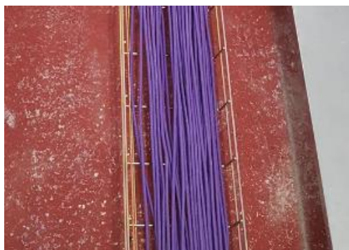
Figura 32 – Tendido de cable por bandeja sin disposición en mazos
